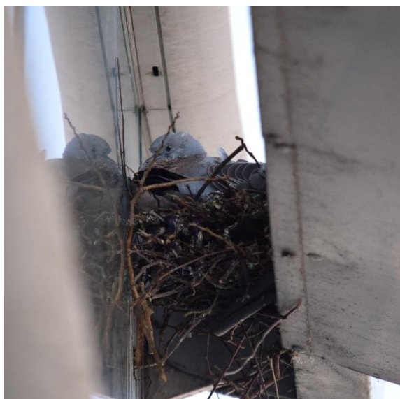
Photo 34 : Nid d'un pigeon domestique au niveau de l'aérogare - AD
